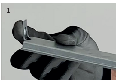
Загніть кінець розпірної планки та відкрутіть гвинт з нижньої частини кріплення.
