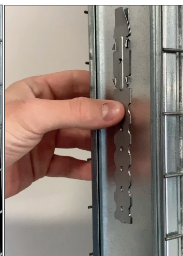
Для гіпсокартонних стін: складіть уже встановлені монтажні пластини на задній частині корпусу. Це можливо за необхідності встановити монтажні пластини та закріпіть їх через гвинтом.
