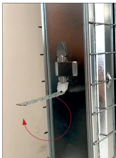
Для гіпсокартонних стін: складіть уже встановлені монтажні пластини на задній частині корпусу. Це можливо за необхідності встановити монтажні пластини та закріпіть їх через гвинтом.
