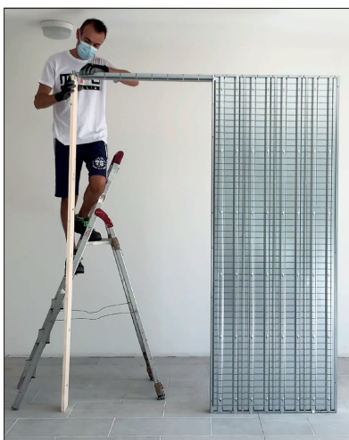
Розташуйте стійку вертикально та загніть вухка, щоб зафіксувати її.
