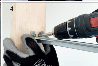
Зігніть обидва кінці розпірки як показано на малюнках 1 і 2. Прикріпіть розпірку за допомогою відповідного гнізда 3 з іншого боку закріпіть до стійки гвинтом 4.
