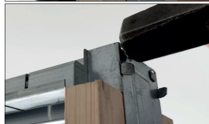
Розташуйте стійку вертикально та загніть вухка, щоб зафіксувати її.
