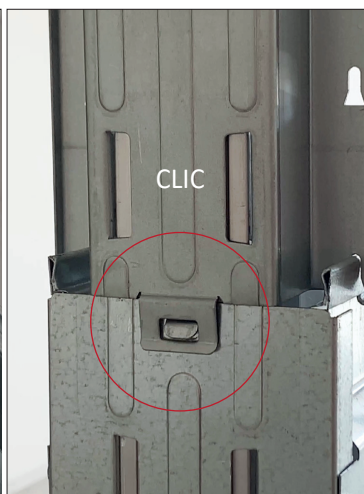
Встановіть направляючу рейку в пенал до «кляцання».
